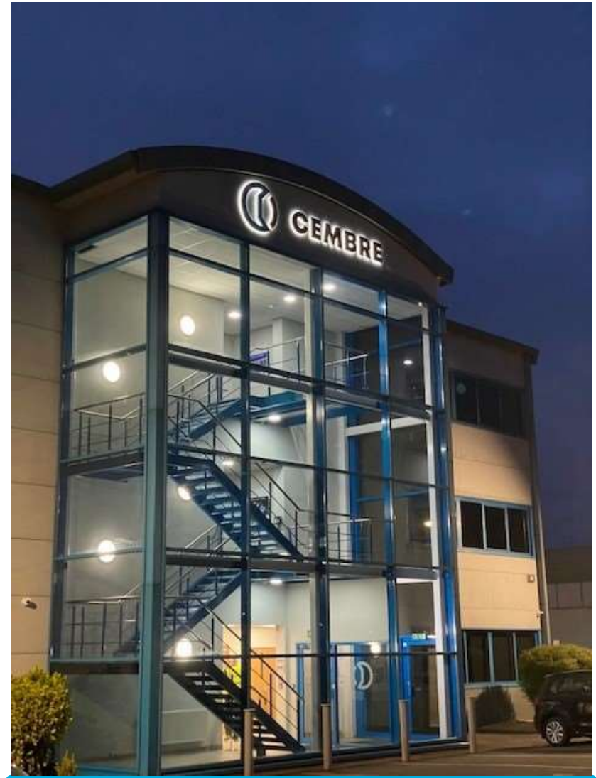
CEMBRE Ltd. – Stabilimento a Curdworth Birmingham (UK)
