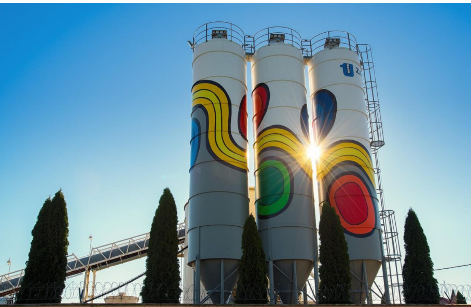
Impianto di produzione di calcestruzzo, Hlohovec, Slovacchia
