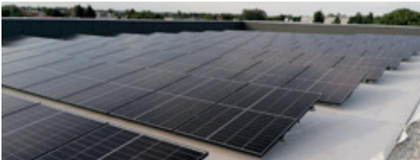
Pannelli fotovoltaici sul tetto per una potenza di 54 kWp che permetterà l'autoproduzione dei fabbisogni della mensa in utilizzo medio
